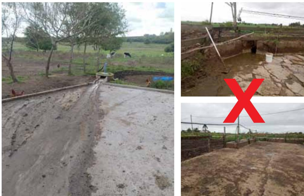
**Figura N° 12.** Planchada de espera con pendiente a zona de conducción y almacenamiento de efluentes. Cuenta con zócalo para evitar desvío del efluente a terreno.
