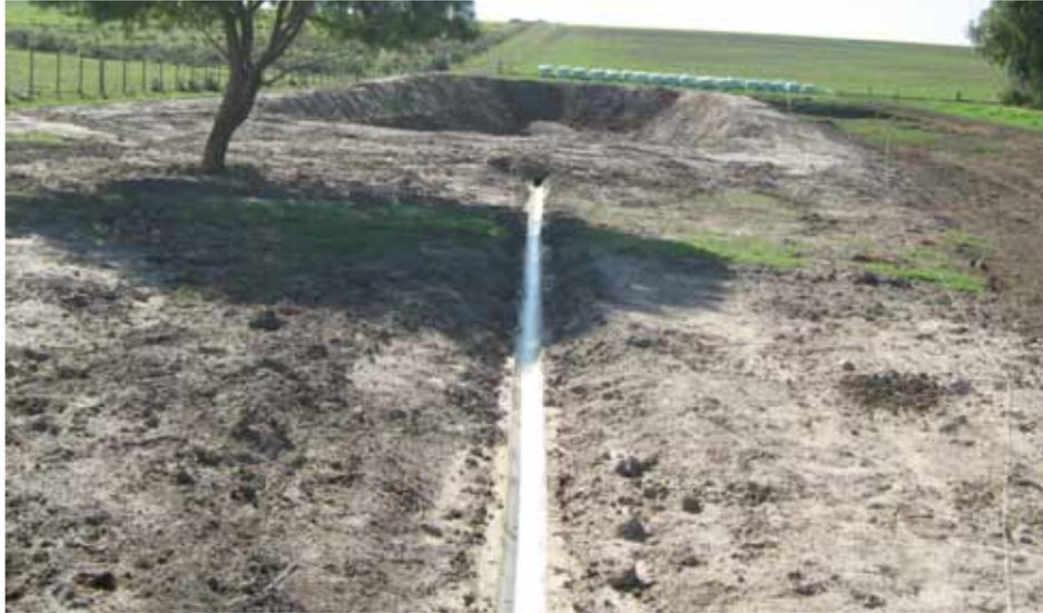
**Figura N° 21.** Canalización de efluente semientubado, con terreno no nivelado
