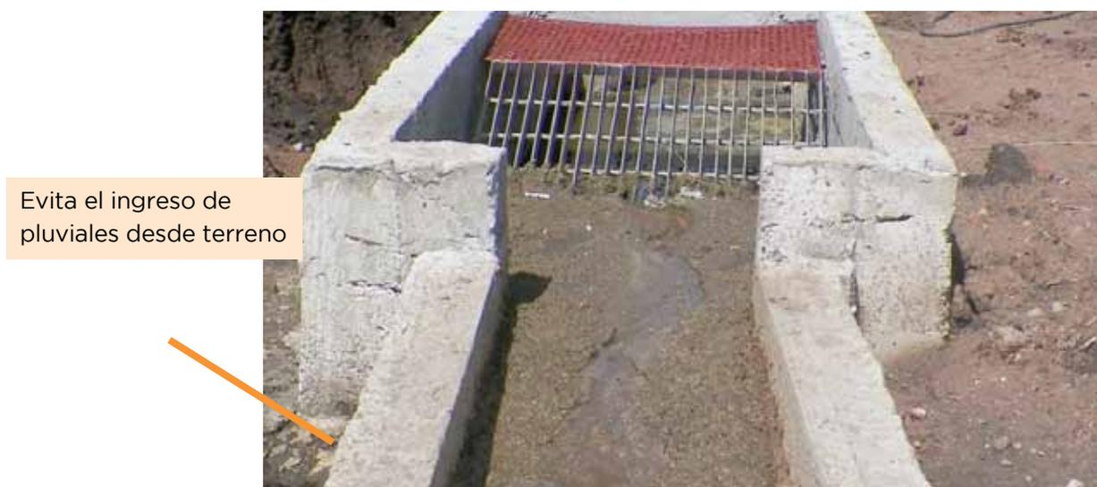
Figura N° 17. Conducción de efluentes por canalizaciones hormigonada con zócalo para evitar el ingreso de pluviales por escurrimiento e infiltraciones.
