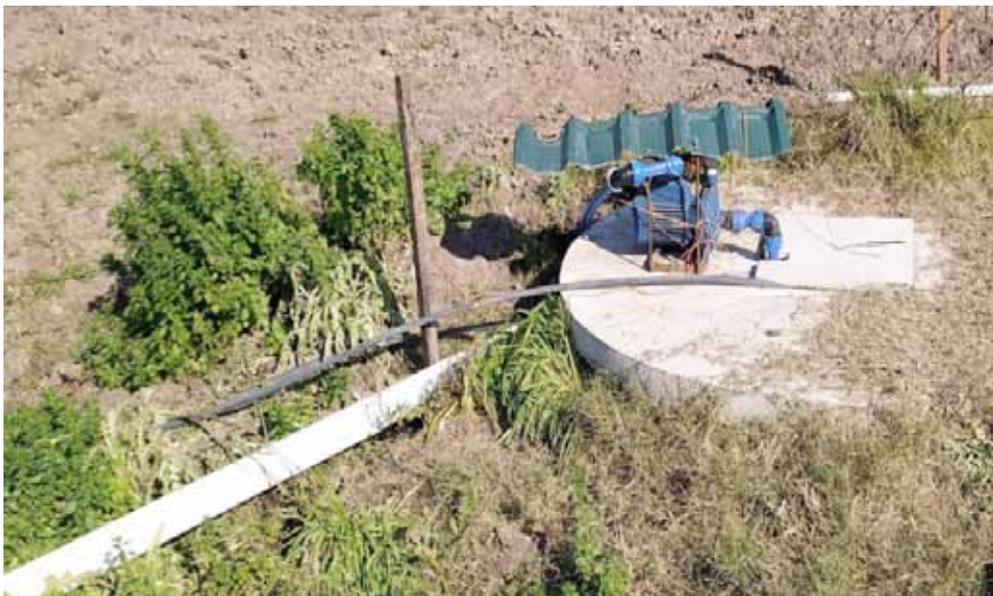
**Figura N° 34.** Tanques de almacenamiento de efluentes enterrados
