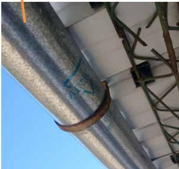
**Figura N° 15.** Captación y desvío de pluviales de techos.
