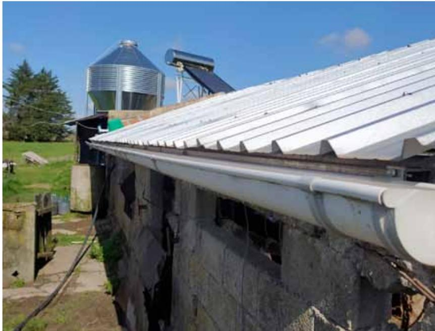
**Figura N° 14.** Captación de pluviales de techos.
