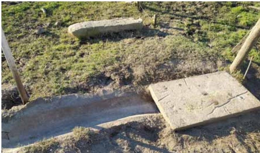
**Figura N° 43.** Conducción del efluente desde zona de generación a laguna
