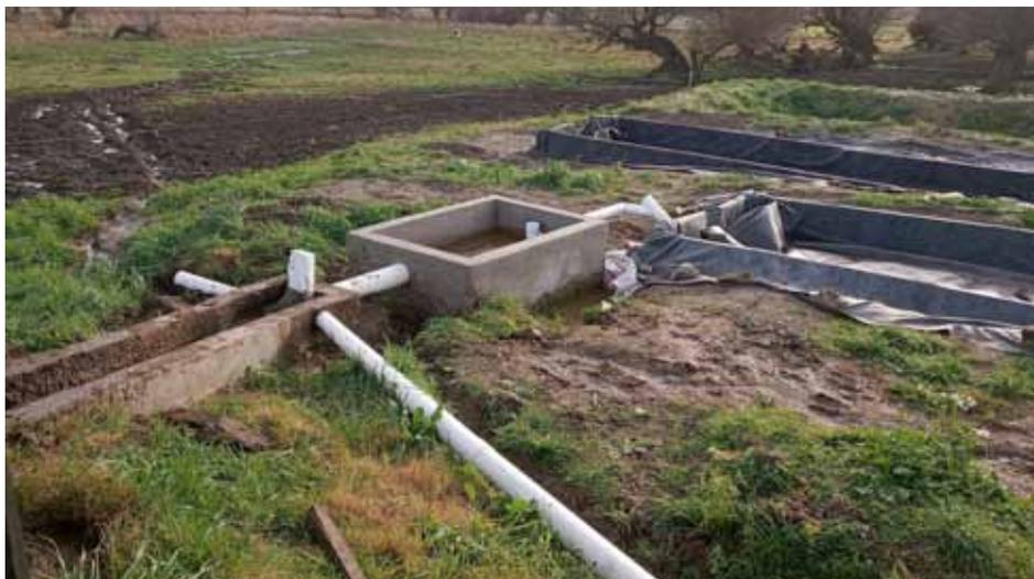
**Figura N° 20.** Canalizaciones de efluentes cerrados o entubado
