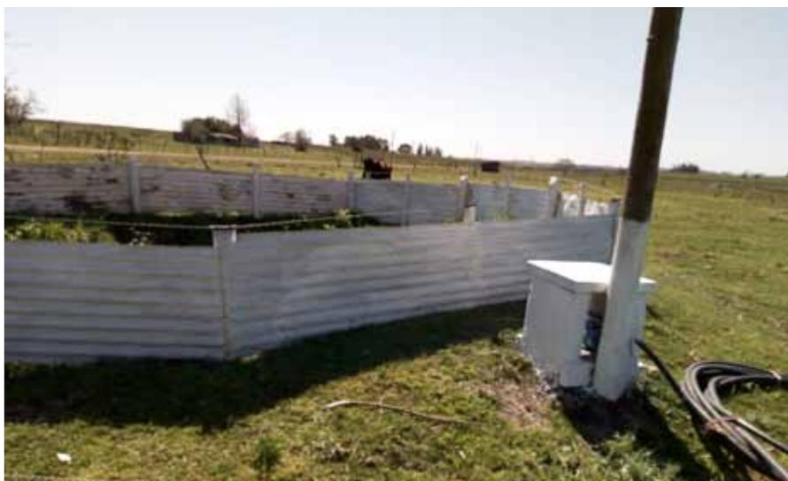
**Figura N° 44.** Laguna de acumulación de efluente, casilla de bombeo y manguera de distribución de efluente
