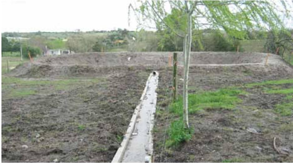
**Figura N° 18.** Conducción de efluentes por canalizaciones hormigonada con zócalo para evitar el ingreso de pluviales por escurrimiento e infiltraciones.
