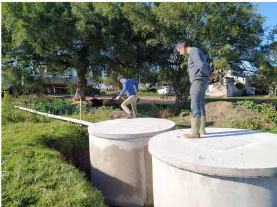
**Figura N° 39.** Instalación de tanque de hormigón en el predio.
