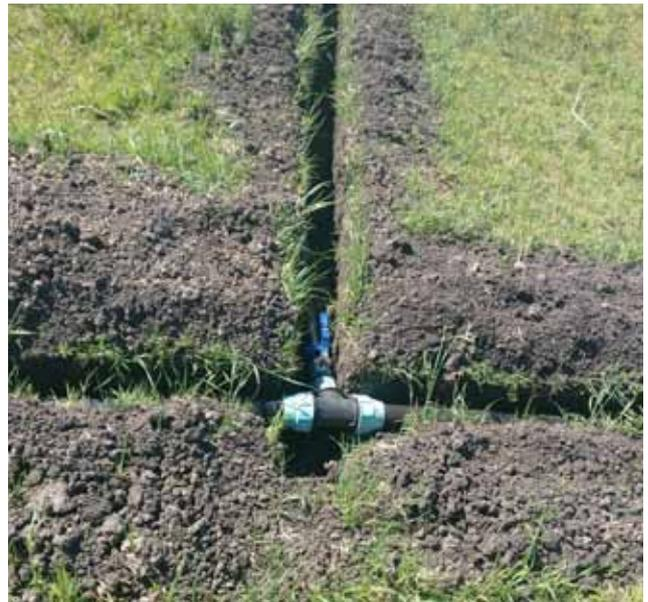
**Figura N° 28.** Instalación de tubería de distribución de efluente bajo tierra. a) tubería (líneas madre) de conducción de efluente desde zona de almacenamiento a zona de distribución a campo. b) Ensamble (T) y conectores de tubería.
