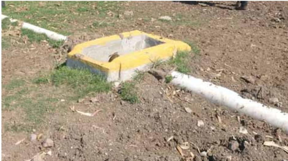
**Figura N° 19.** Canalizaciones de efluentes cerrados o entubado
