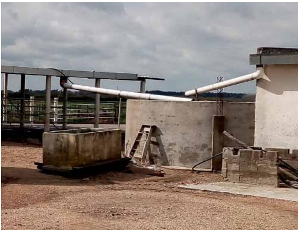
**Figura N° 13.** Recolección de pluviales a) Captación de pluviales de techos (tambo y galpón).
