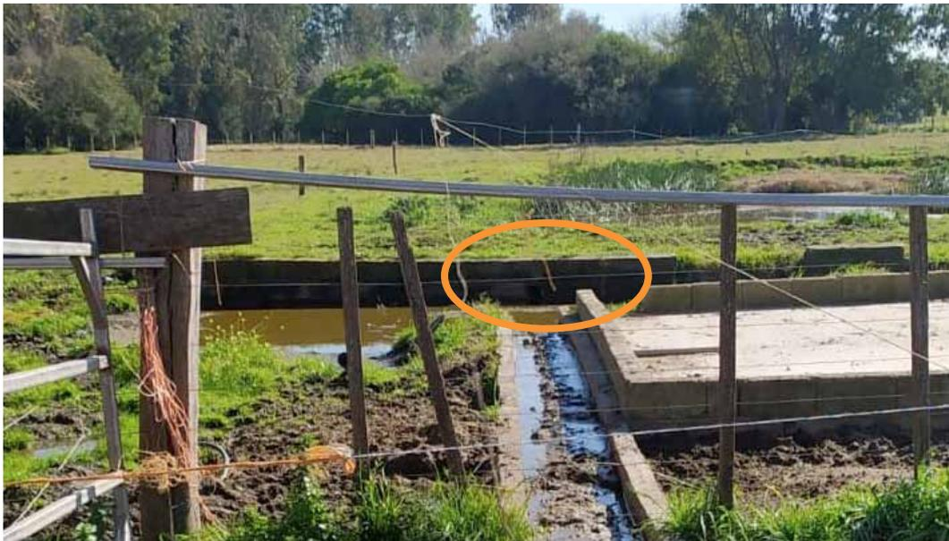
**Figura N° 11.** Planchada para almacenar o apilar estiércol con canalización al sistema de almacenamiento de efluente
