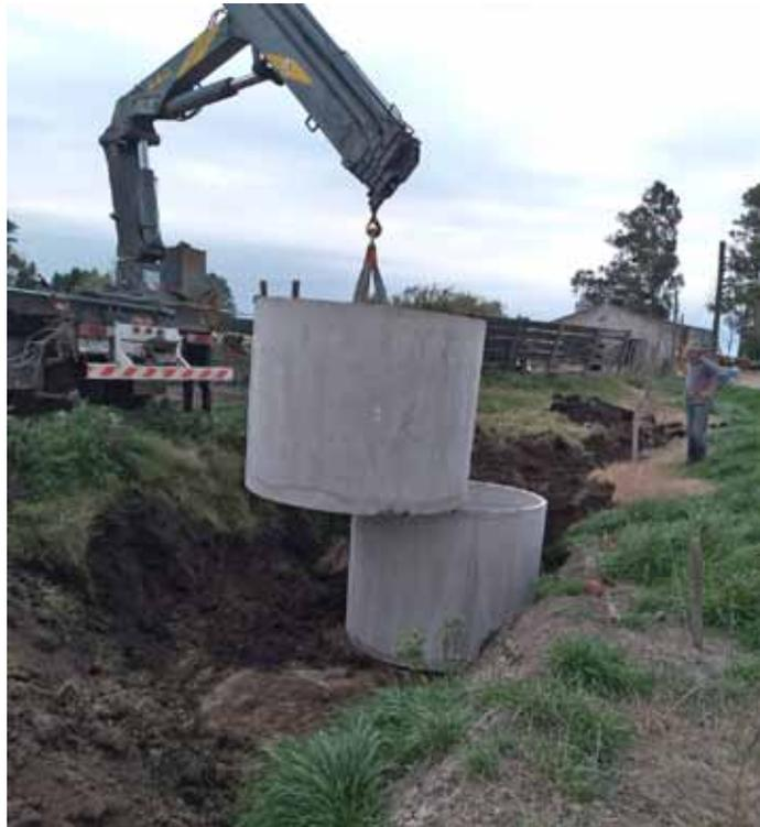
**Figura N° 38.** Instalación de tanque de hormigón en el predio.
